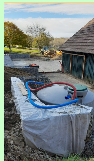
Installation d'un récupérateur d'eau de pluie
